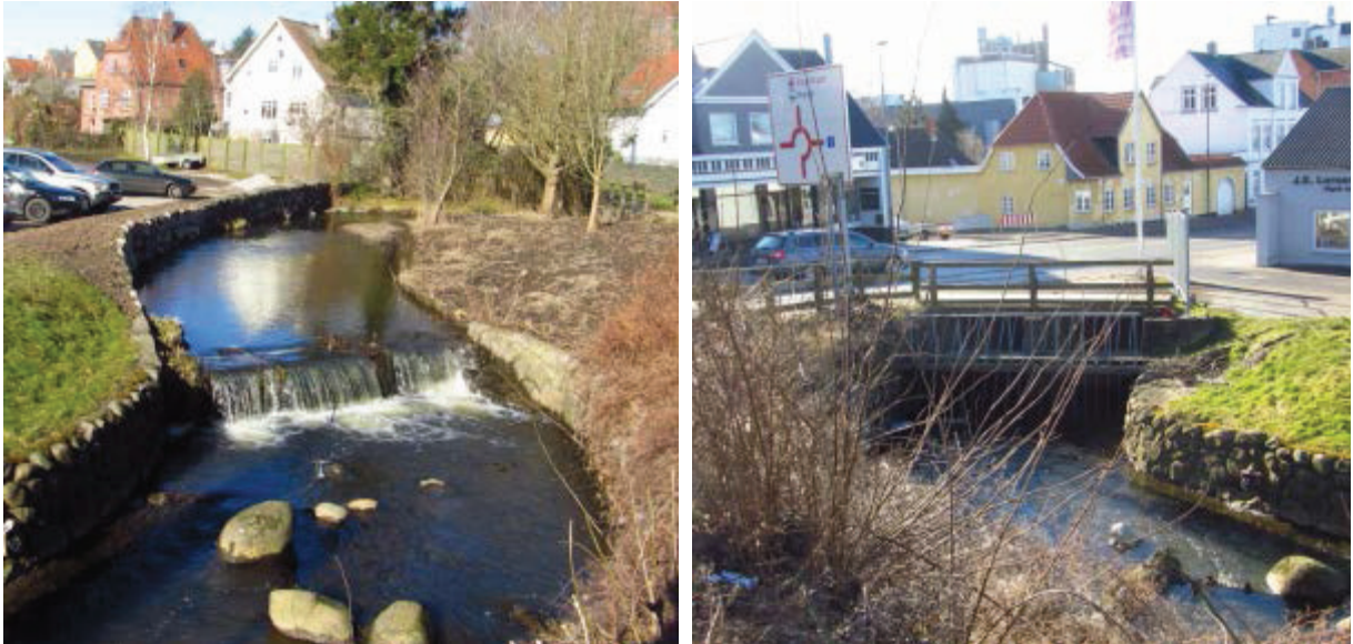
Figur 5 T.v. Mindre opstemning nederste Ørkilds Mølle. T.h. Kobberbækkens indløb til den rørlagte strækning. Som en del af rørlægning er der et større styrt, der sandsynligvis er en bevarelse af den gamle frisluse for nederste Ørkilds Mølledam.
