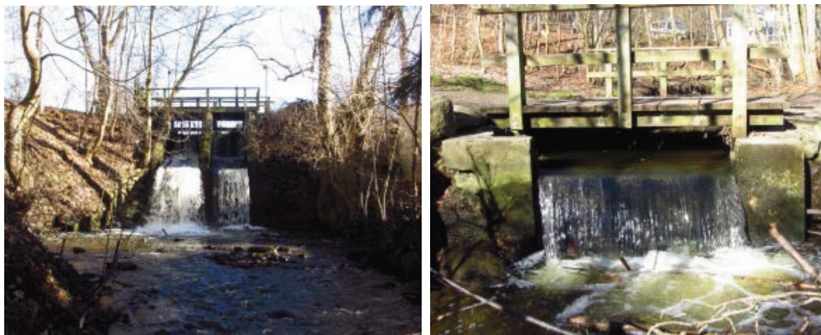
Figur 4 T.v. Opstemning (frislusen) for øverste Ørkilds Mølle. T.h. Opstemning i Trappebækken til indtag af vand til dam ved Caroline Amalie Vej (beliggende nordvest for Ørkilds Mølledam)
