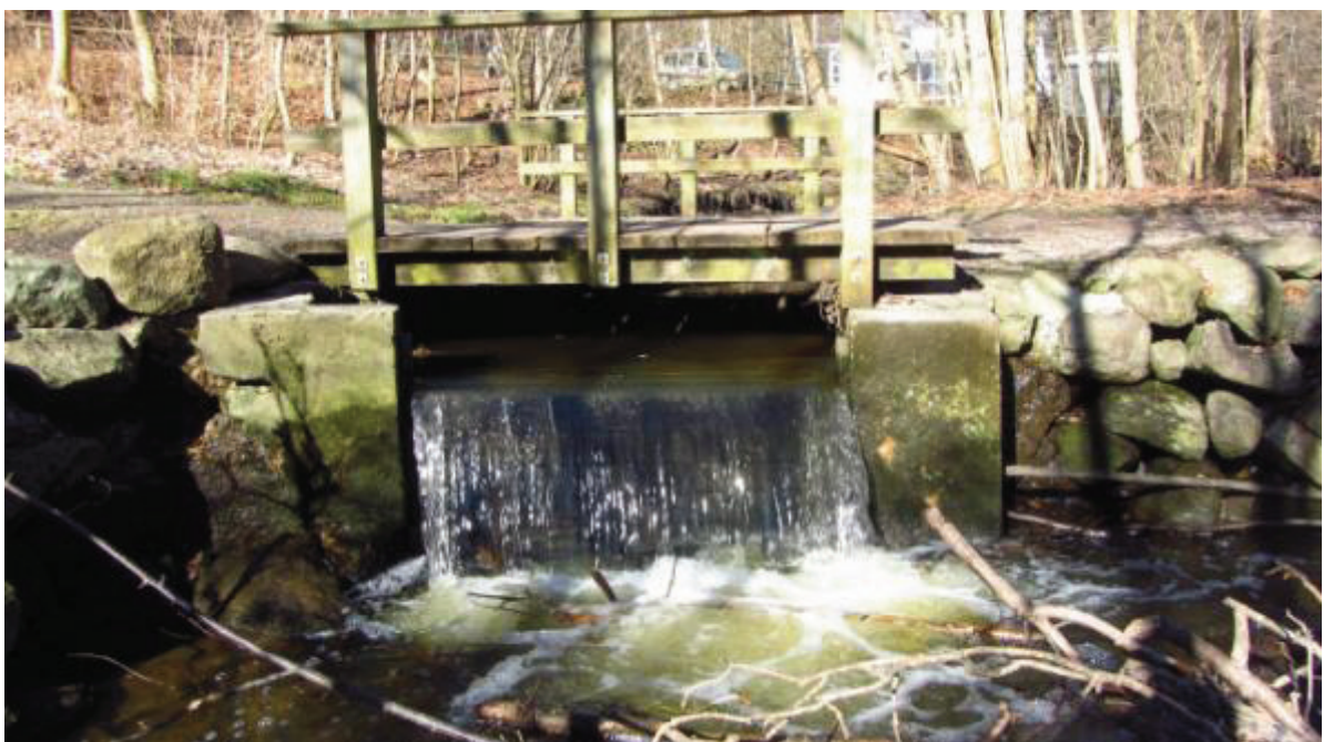
Figur 35 Øverste opstemning i Trappebækken. Her er der i dag et indtag under broen via et rør til dammen langs med Caroline Amalie Vej.
