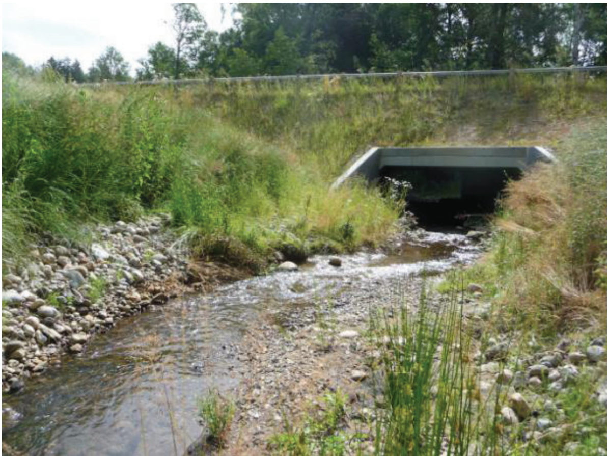
Figur 34 Eksempel på firkant betonelementtunnel fra Perstrup.
