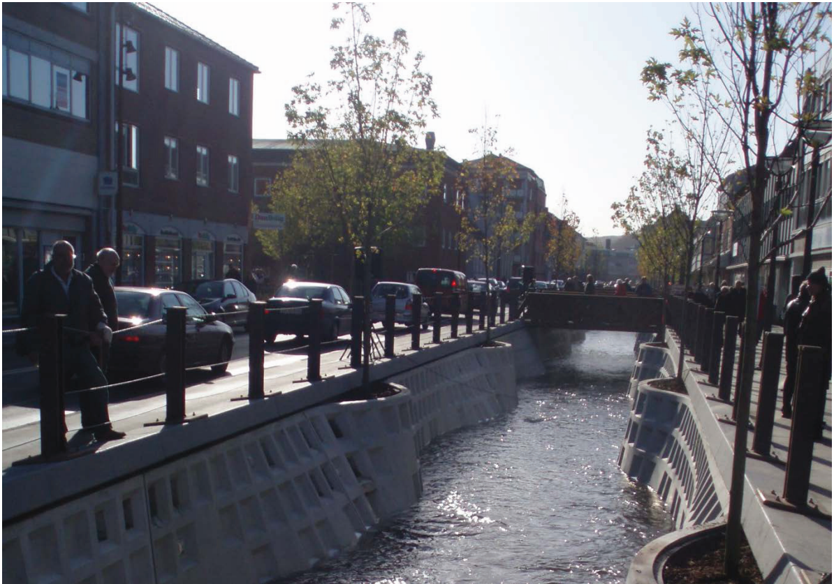
Figur 40 Eksempel på åbning af rørlagt vandløb. Grejs Å gennem Vejle.
