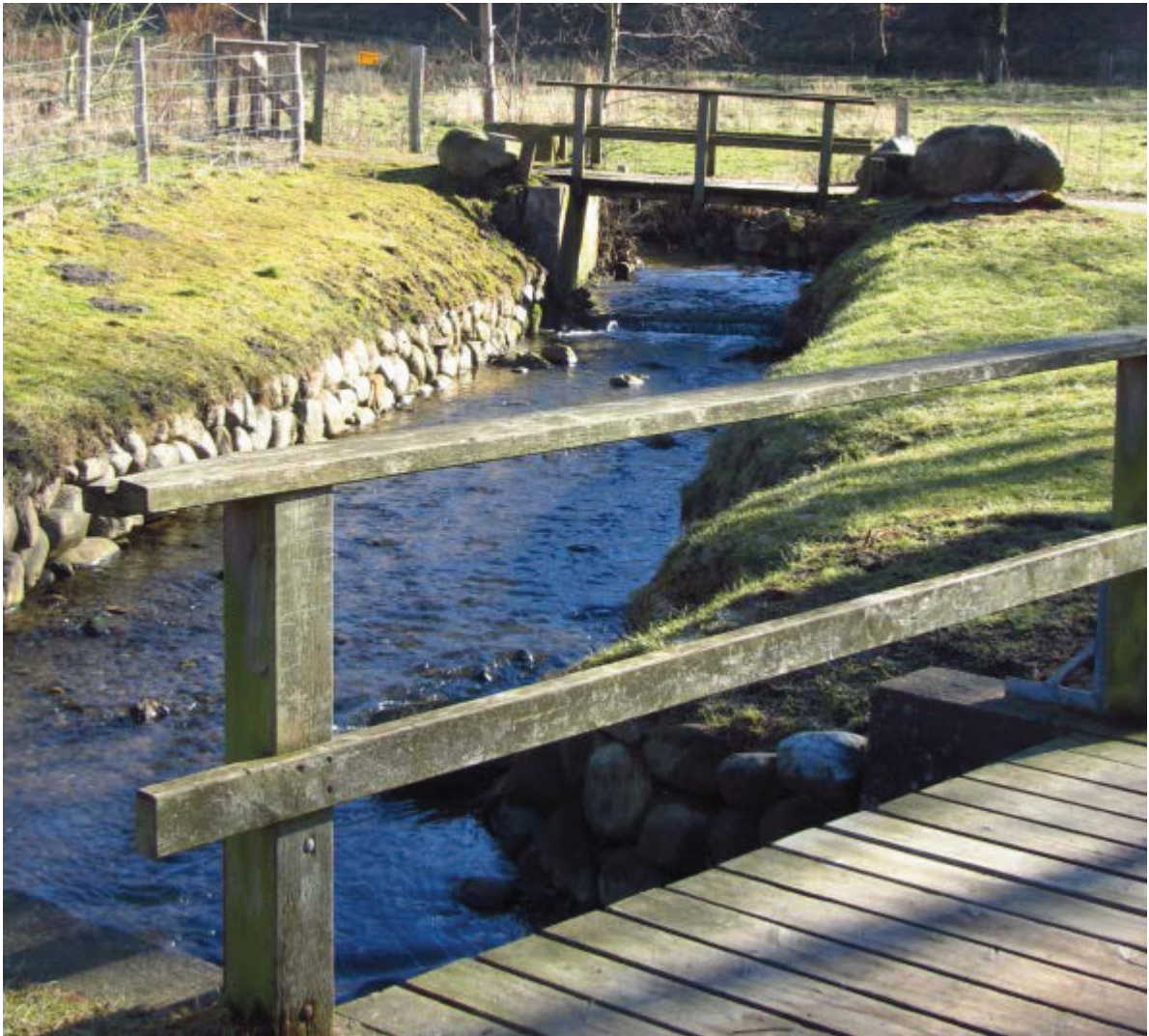
Figur 33 Stensætning af eksisterende Kobberbækken. Samme sider vil blive udført for Trappebækken for det nye forløb mellem St. 885 m og St. 810 m.
