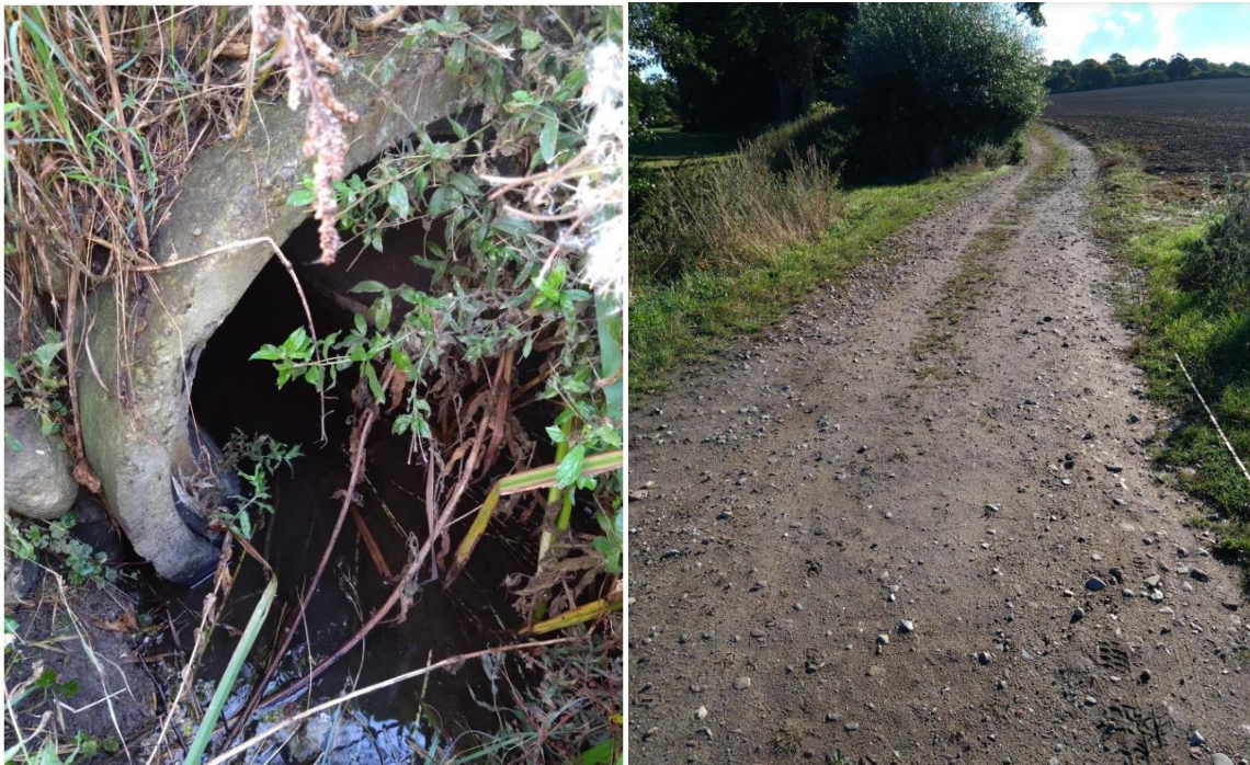
Figur 2.1: Fotos af eksisterende betonrør og overkørsel ved Broholm
