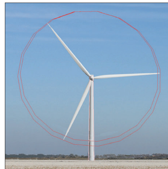
Figur 2.3. Forskelle i de to mølletypers rotordiameter.
