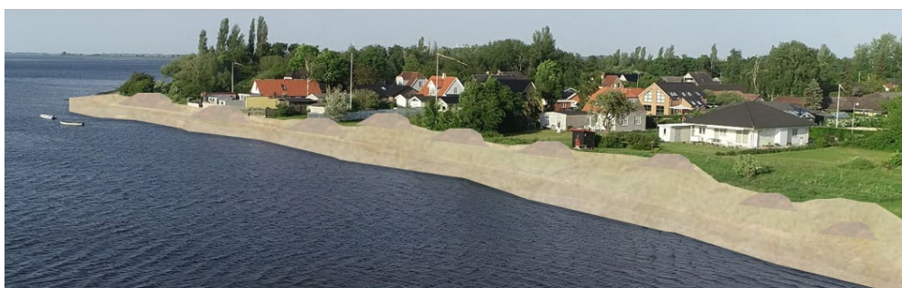
Figur 6 Højvandsbeskyttelse i form af en klitrække
