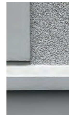
Skyggevirkning i facaden Materialerreference
