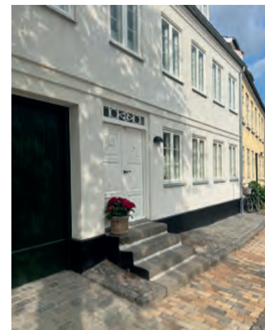
Kantzone foran byhuse Kullinggade 24
