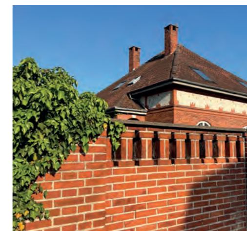
Gennemgåede røde teglsten Færgevej 3
