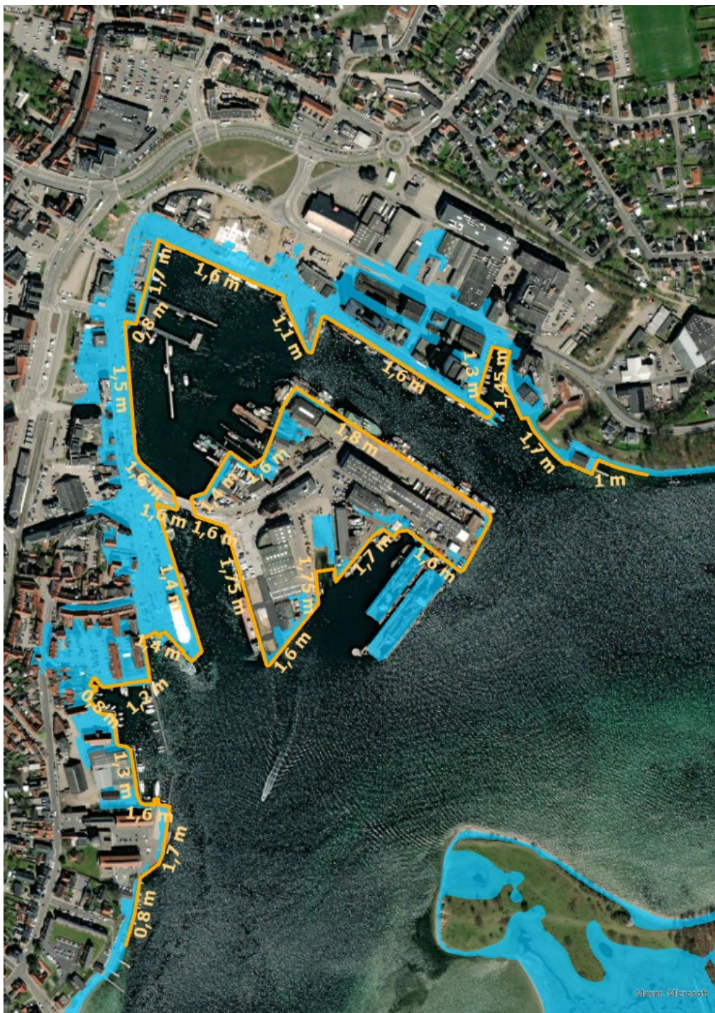
Figur 19: Kajkanters koteforhold og strækninger som oversvømmelses ved vandstande op til ca. 166 cm, svarende til en nutidig 20-års hændelse.
