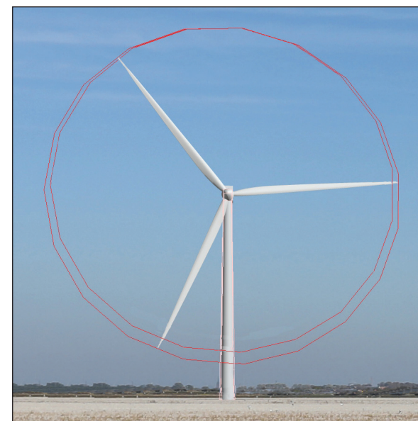
Figur 2.3. Forskelle i de to mølletypers rotordiameter.
