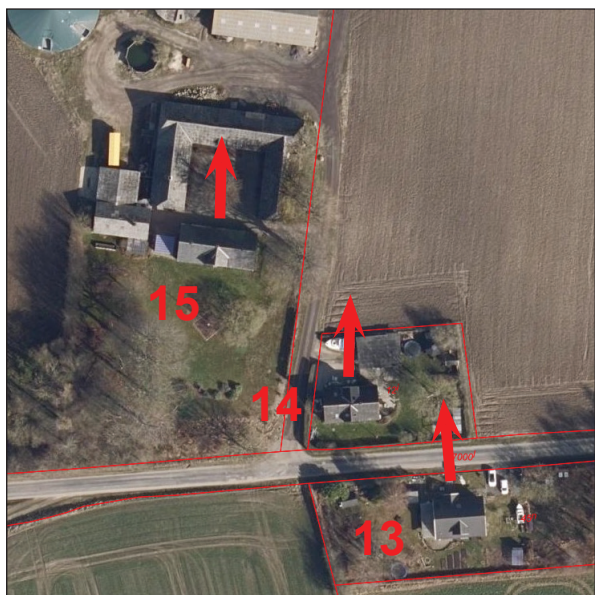
Figur 4.9. Nabo 13-15 – Fuglehavevej 14, 9 og 7.
