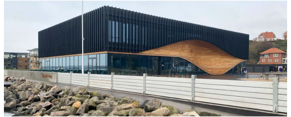
Figur 2: Eksempel på stormflodssikringsdige i en stormflodssituation, opbygget af stabelbare planker.
