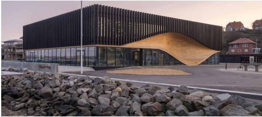
Figur 1: Eksempel på stormflodssikringsdige i en hverdagsituation (venstre side af billede) med åben strækning (højre side) der kan lukkes med stabelbare planker ved varsling.
