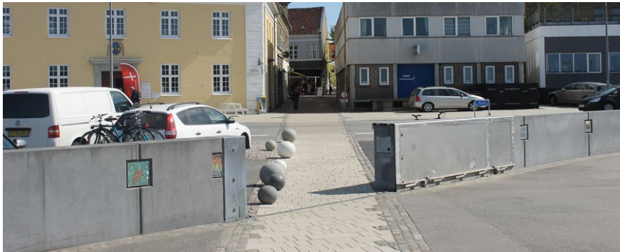
Figur 3: Eksempel på stormflodssikringsdige i en hverdagsituation, med åbning der kan lukkes med skydeport ved varsling.
