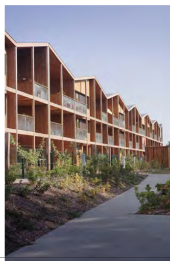
Træ facade indeliggende altaner.
