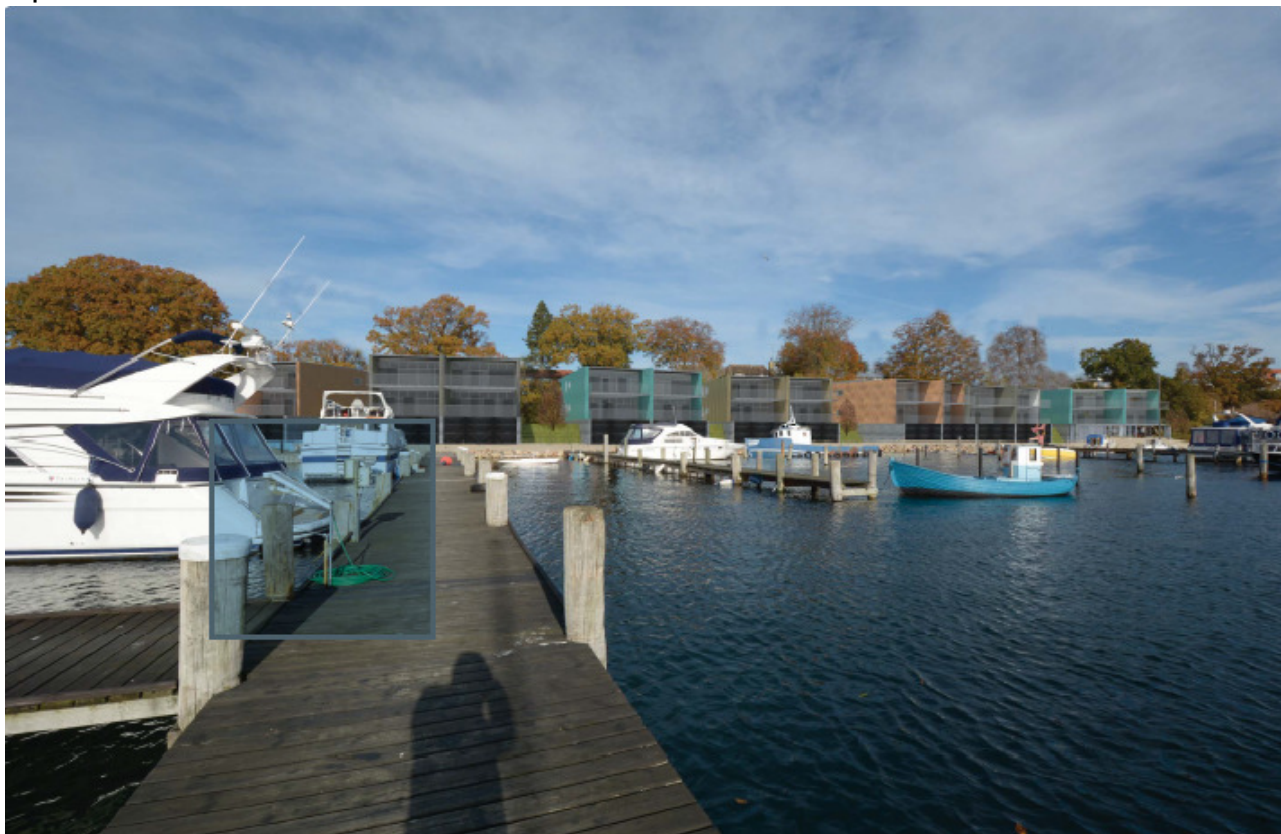
Samme standpunkt visende punkthusene - redskabsrum foran parkeringsdæk og 1. og 2. sals legligheder.
