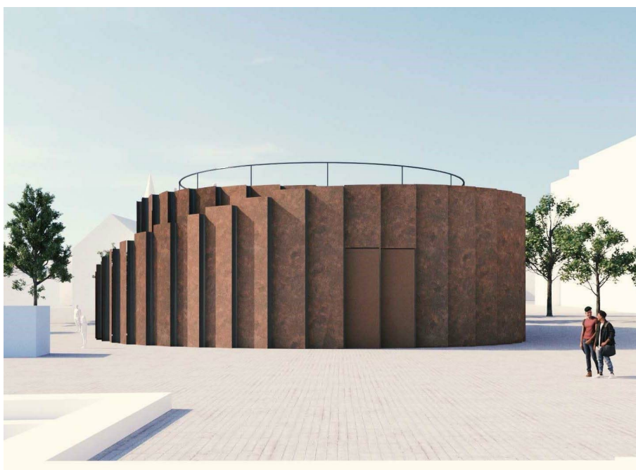
Illustration af hvordan facaden beklædes med skærme eller plader monteret i fortanding (Ginnerup Arkitekter).
