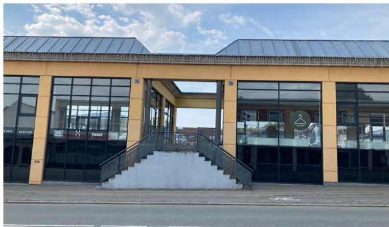
Tydlig offentlig adgang til taget.
