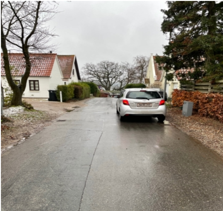
Foto 3: Opmarch ved signalanlæg i sydlig køreretning. Der skal sideudvides med asfalt inden ibrugtagning af signalanlægget med plads til en tydelig og korrekt opmarchafmærkning, med mulighed for afvikling af trafikken, uden fare for opstuvning ved signalanlægget.
