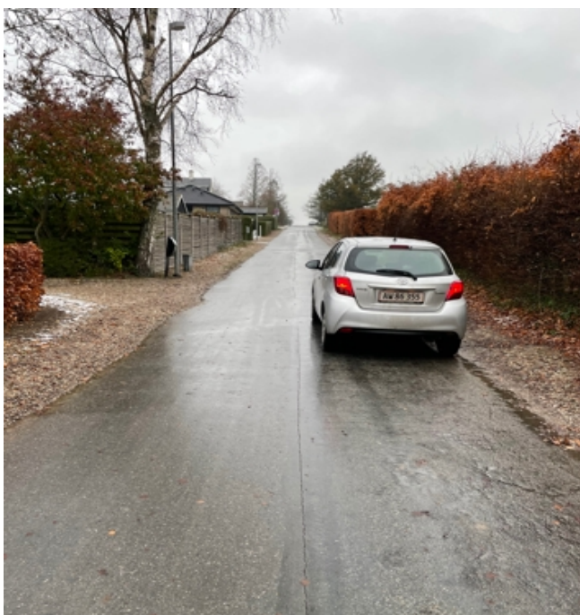
Foto 1: Delstrækning 1 set i nordlig køreretning. Det vurderes at der ikke er tilstrækkelig plads til en sikker passage mellem to personbiler ved lav hastighed indenfor den nuværende kørebanebredde/asfaltbelægning.
