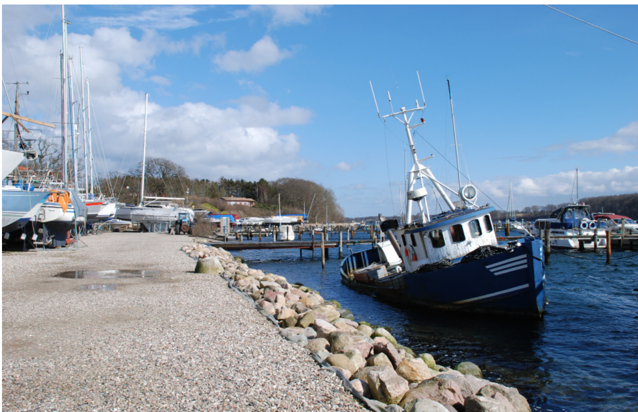
Nyrenoveret stensætning danner lokalplanens afgrænsning mod kysten. Lokalplanens afgrænsning udgøres af de moler og stensætninger som er godkendt af Kystdirektoratet
