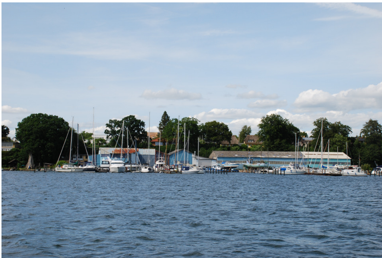
Thurøbunds karakteristisk blå værftsbygninger, som ifølge lokalplanen kan nedrives og erstattes med nyt boligbyggeri. Den nye boligbebyggelse skal ske som punkthuse i 2-3 etager, dog max samme højde som erhvervsbygningerne.
