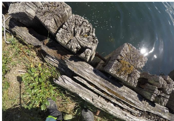
Figur 7: Kraftig nedbrydning af hammeren.
