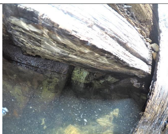
Figur 4: Bagvedliggende ældre kajkonstruktion. (Foto er taget med GoPro-kamera, hvilket giver en lille forvrængning af billedet.)
