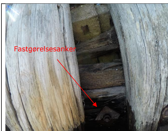
Figur 3: Træspuns med reparation af letvægtsbeton. (Foto er taget med GoPro-kamera, hvilket giver en lille forvrængning af billedet.)
