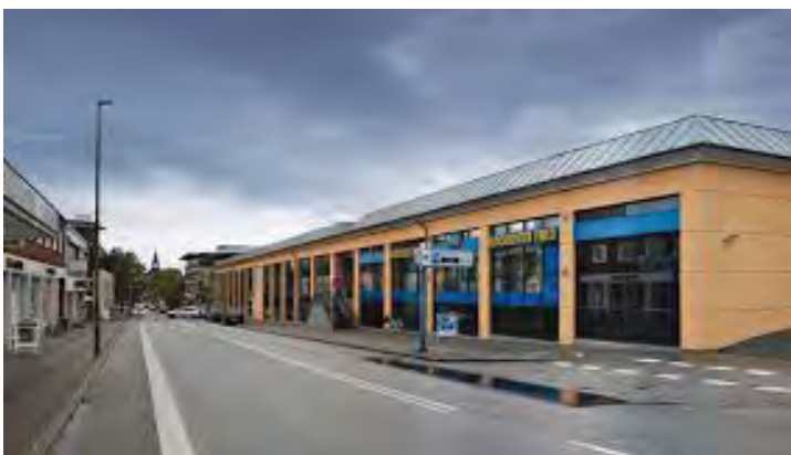
Lang, ensformig og lukket facade i øjenhøjde, med kun en enkelt adgang.
