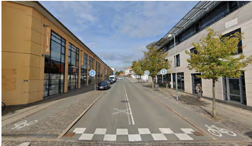
Tinghusgade er en af de få gader i Svendborg med sikker hævet adskilt cykelsti, med enkelte gadetræer og brede fortove.
