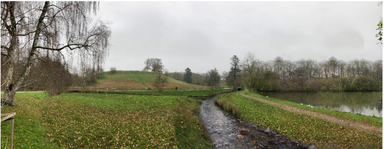
Efter – vest for den nye afgrænsning af mølledammen føres Trappebækken og Kobberbækken til et nyt sammenløb og videre forløb gennem den fjernede frisluse.
