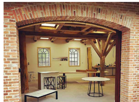
Ombygning af tidligere vandmølle i Vormark med støtte fra LAG-SØM Fotos: COM'N'WOOD
