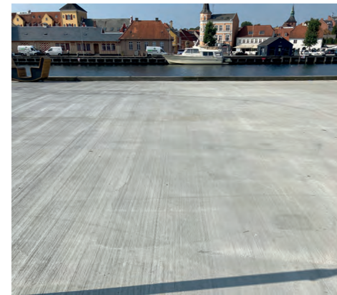
Udtrøstningskaj, Frederikssø, 2021 In situ støbt og kostet beton i store overflader for at understøtte det industrielle havneudtryk og havnens store skala.
