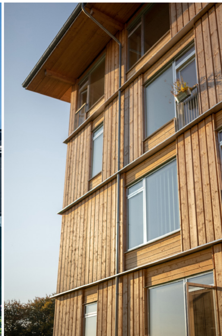
Træbeklædning lodret og vandret En kombination af lodret og vandret træbeklædning er med til at markere særlige felter i facaden.
