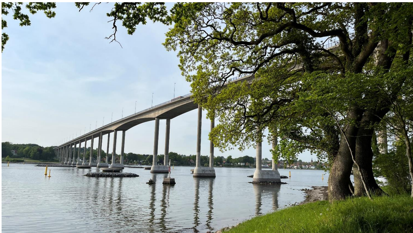
Figur 7.10 Den høje bro over Svendborg Sund gør, at forbindelsen til fastlandet ofte medfører store omveje og derved virker lang.
