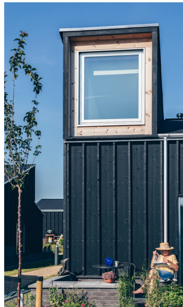
Træbeklædning med dybdeeffekt Træbeklædning med variation i dybden giver facaden en 3D-effekt, som skaber et fint skyggespil og gør facaden mere levende og oplevelsesrig.
