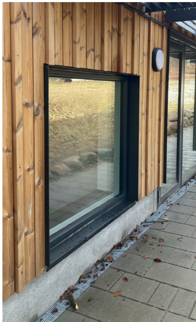
Høj sokkel Den træbeklædte facade designes med en høj sokkel, der beskytter træbeklædningen mod slid og skader.
