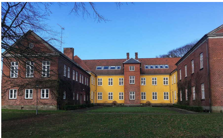
Figur 14 - Foto af hovedbygningen set fra seminariehaven
