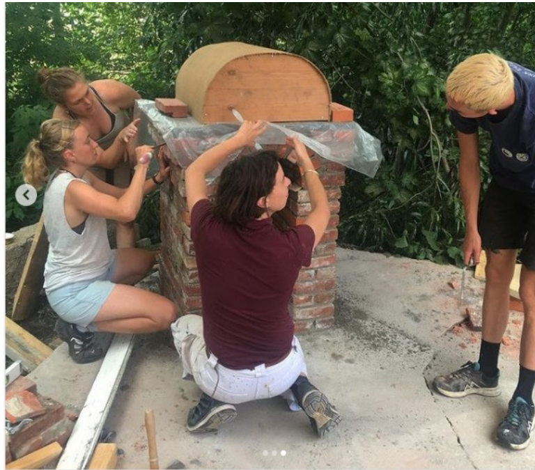
Tid til at lære af hinanden. En pizzaovn opstår af lokale genbrugsmaterialer.
