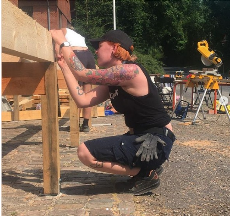
Laura mærker af på terrassens strøer. "Jeg får nye venner og mere netværk på tværs af vores byggefag" Laura N, bygningsnedkerlærling (de/dem)
