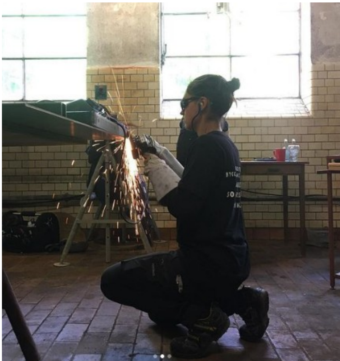
Smedegruppen svejser alle gelænderne til den lange terrasse Afrapportering, håndværkertræffet Under Ombygning 2021
