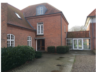
Indgangsparti i tilbygget fløj fra 1952
