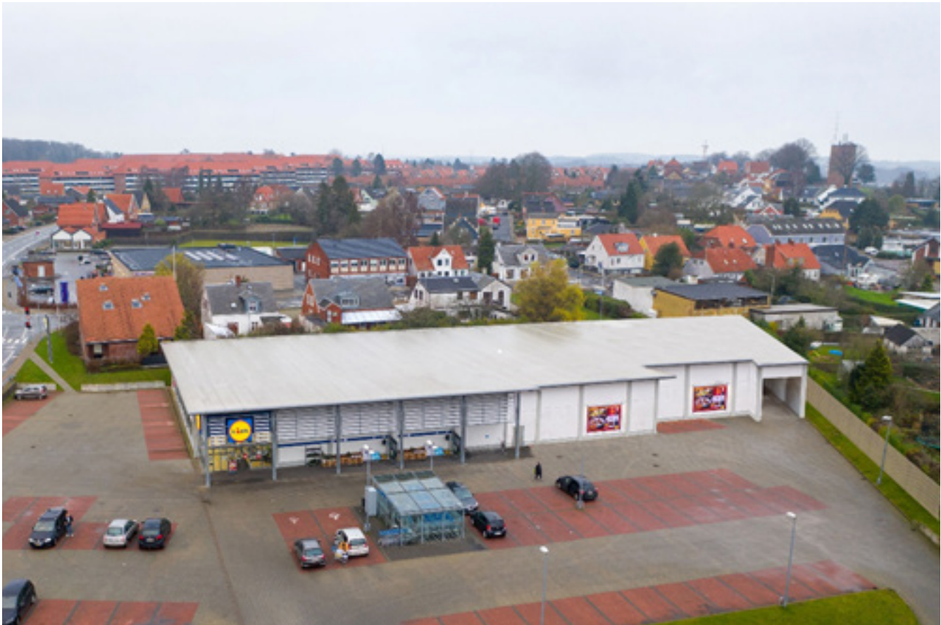
Figur 2. Lokalplanområdet set fra sydvest. Illustrationen viser, hvordan butikken kan udvides mod sydøst. Facaden brydes med facadedetaljer pr. min. 7 m. jævnfør § 7.2.
