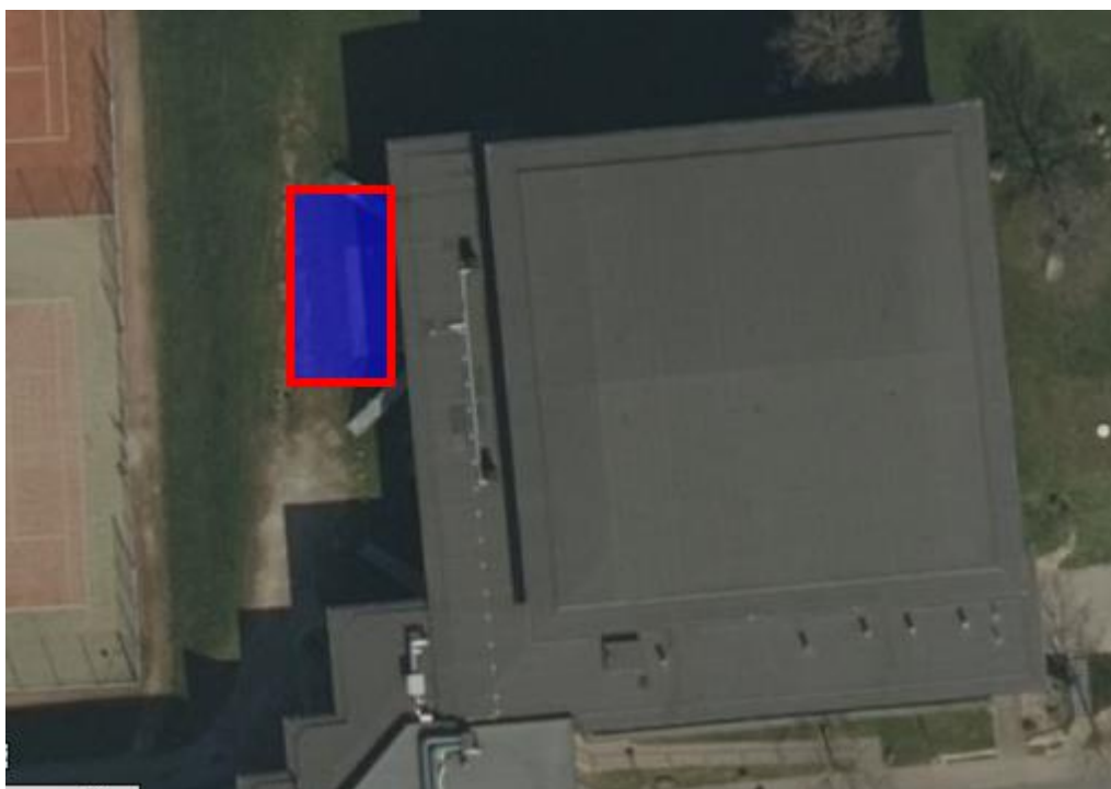
Varmtvandsbassin bygget i tilknytning til Svendborg Svømmeland.
