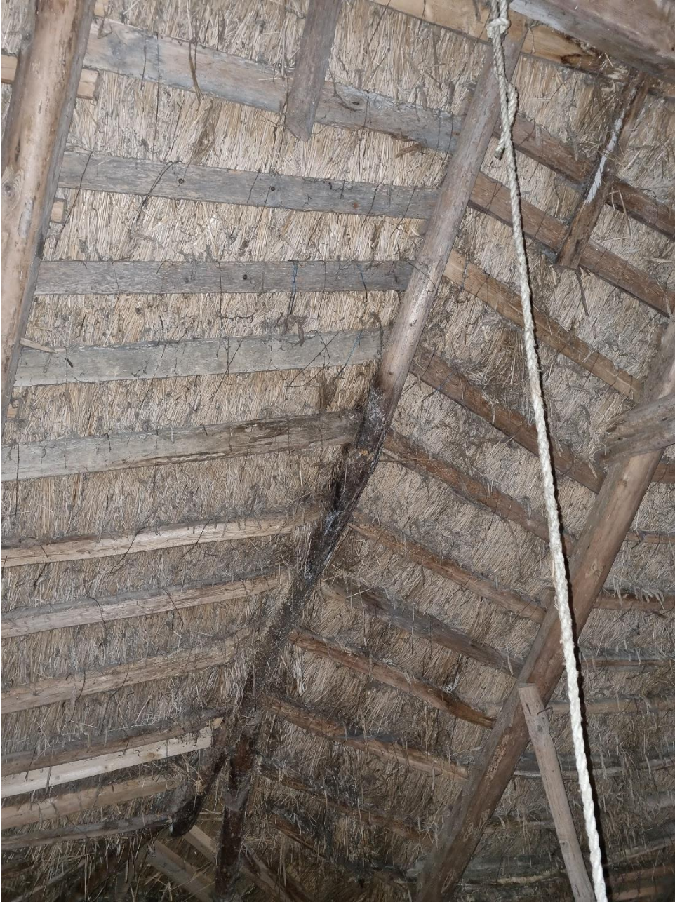
Figur 7 Viser råd i spær på kvist
