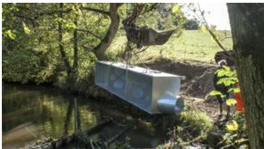
Figur 9: indløbskasse til indløb til Hvilested Dambrug ved Kolding Å/Vester Nebel Å.
