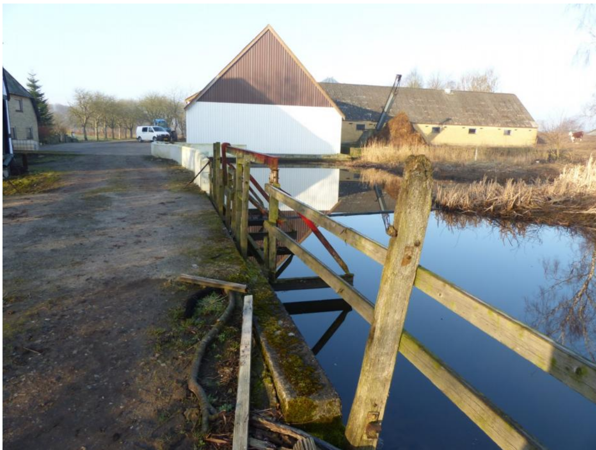
Figur 16 Tilbygning til staldbygning (hvide bygning) helt ud til mølledammen.
