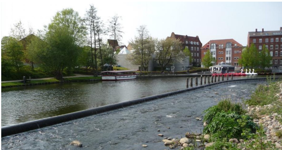
Figur 28 Eksempel på spunsløsning, adskillelse mellem mølledam og omløbsstryg
