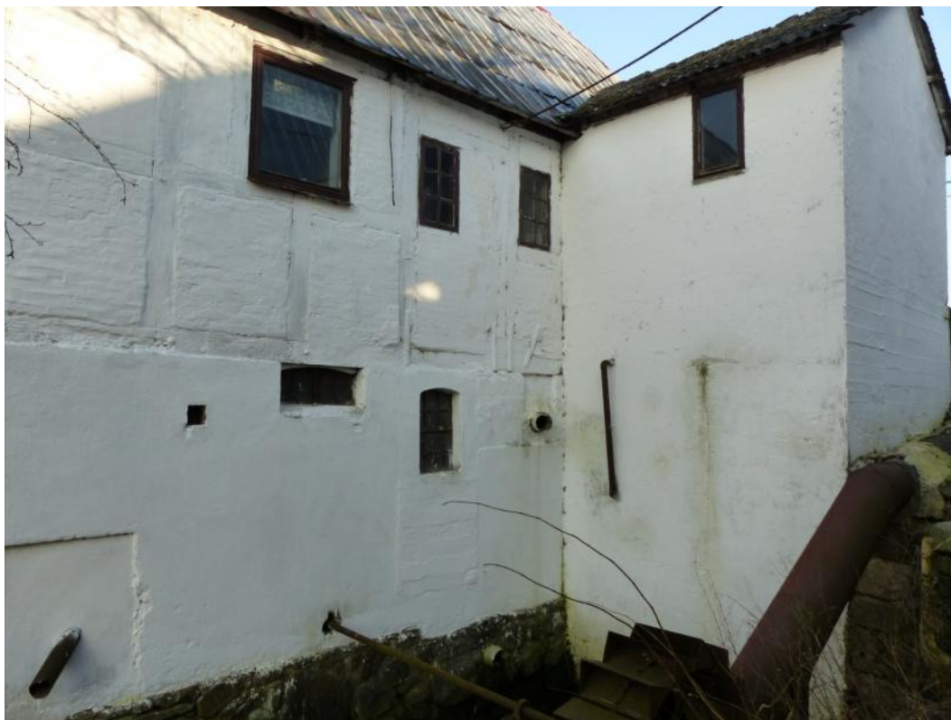
Figur 15 Møllebygning og turbinehus Gundestrup Mølle
