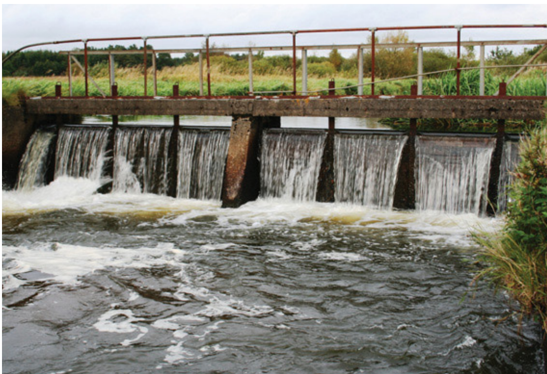
Stemmeværk i Skjernå ved Arnborg som leder vand ind til Skjernå Nørrekanal, Danmarks største engvandingsanlæg.
