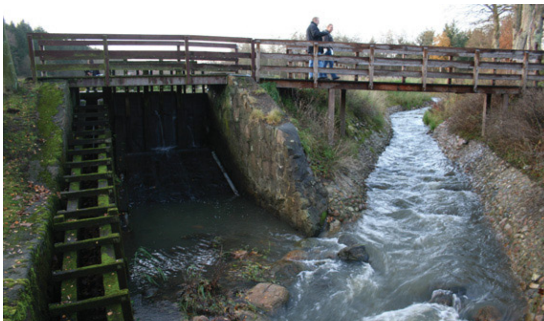
Mødet mellem frislusen og omløbet, hvor det gamle modstrømspas er bevaret. En stenrække er udlagt, der afspærre frislusen for at sikre at unge ål ledes ind i omløbet.
