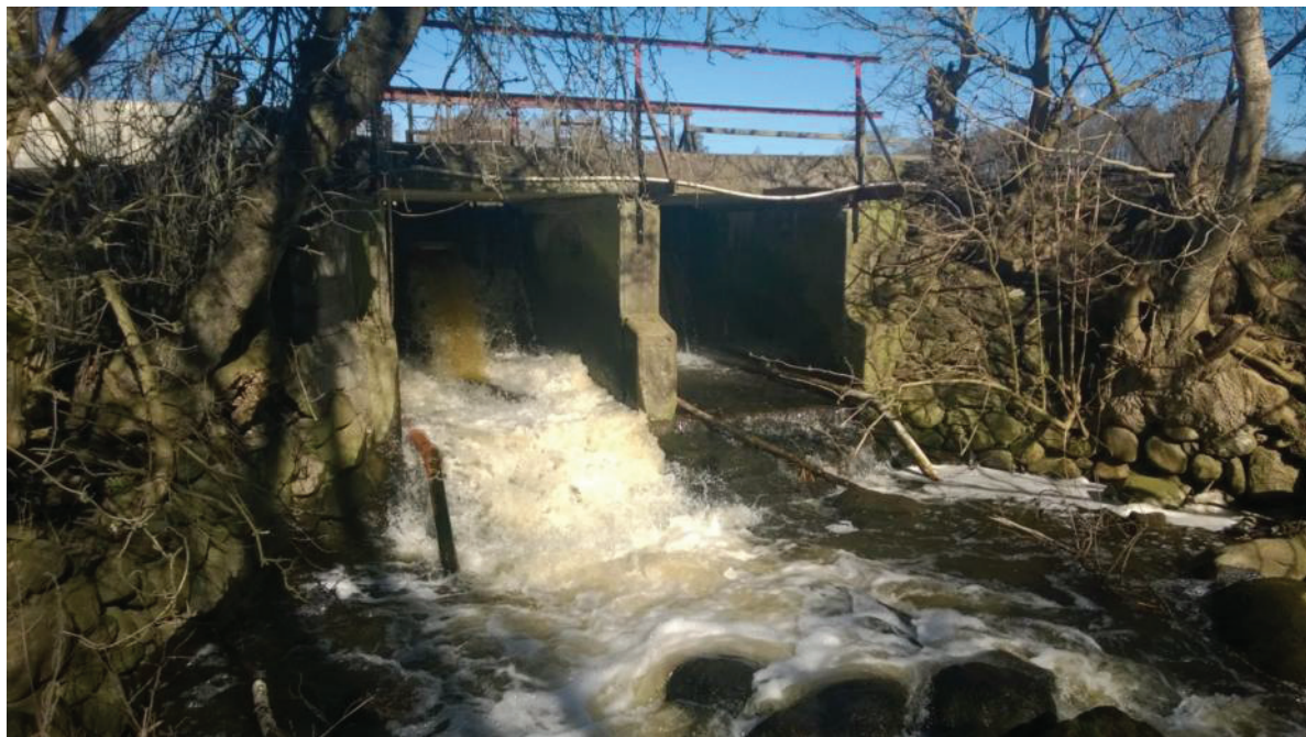
Figur 3 Opstemning og frisluse for Gundestrup Mølle.
