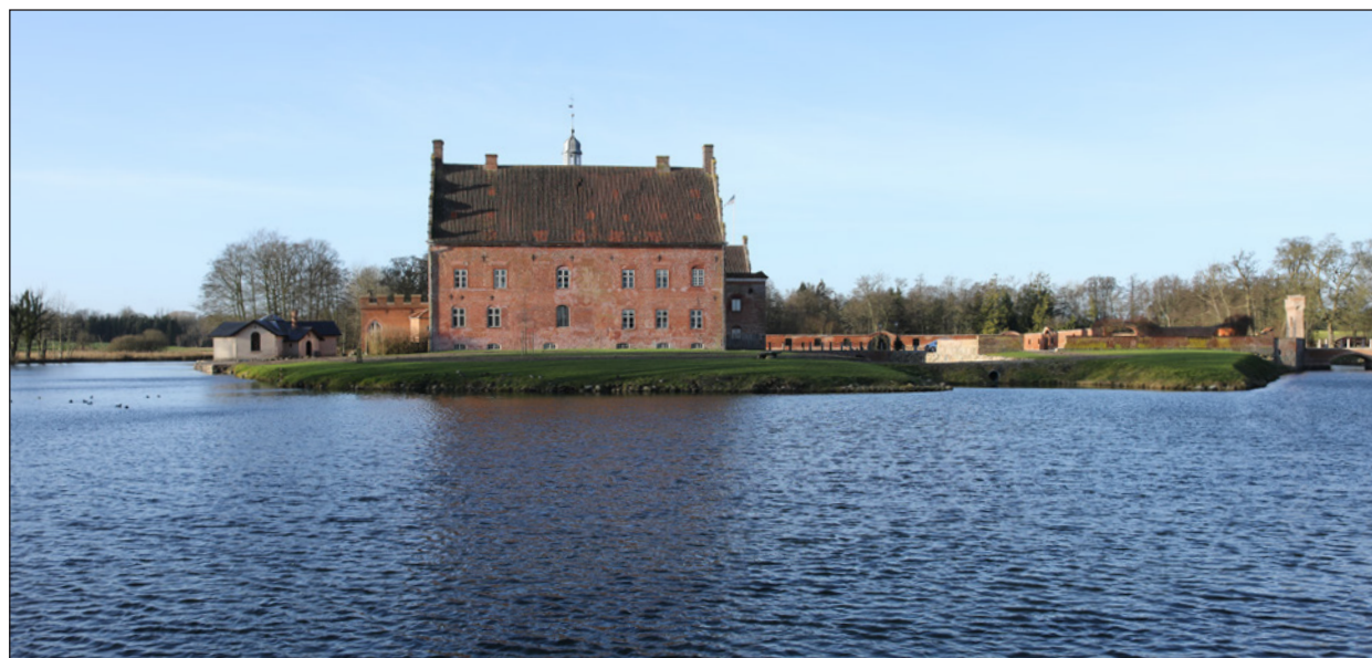
Figur 3.4. Broholm set fra øst - i modsat retning af vindmøllerne - ved Broholmsvej tæt ved Landevejen.
