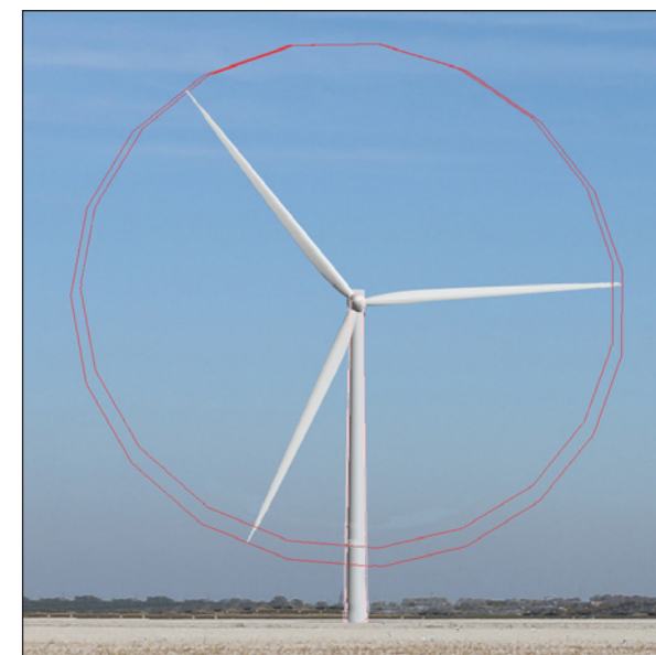
Figur 2.3. Forskelle i de to mølletypers rotordiameter.
