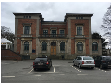
Foto af Amtmandsvillaen fra den fælles parkeringsplads mod nord. Villaen er inspireret af italiensk byggestil og opført i røde mursten og sandsten. Taget er udført i kobber og naturskiffer. Grønne vinduer og dører understreger det italienske udtryk.
