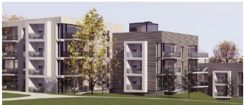
Princip for facadeudtryk og materialer, samt princip for altaner. Facaderne er vist med listebeklædninger i træ. De indbyggede altaner, udført i eks. beton tilfører en spændstighed i udtrykket og en kontrast i materialevalget. Fælles for alle altaner er, at de er udført med et let udtryk eks. værn i glas.
