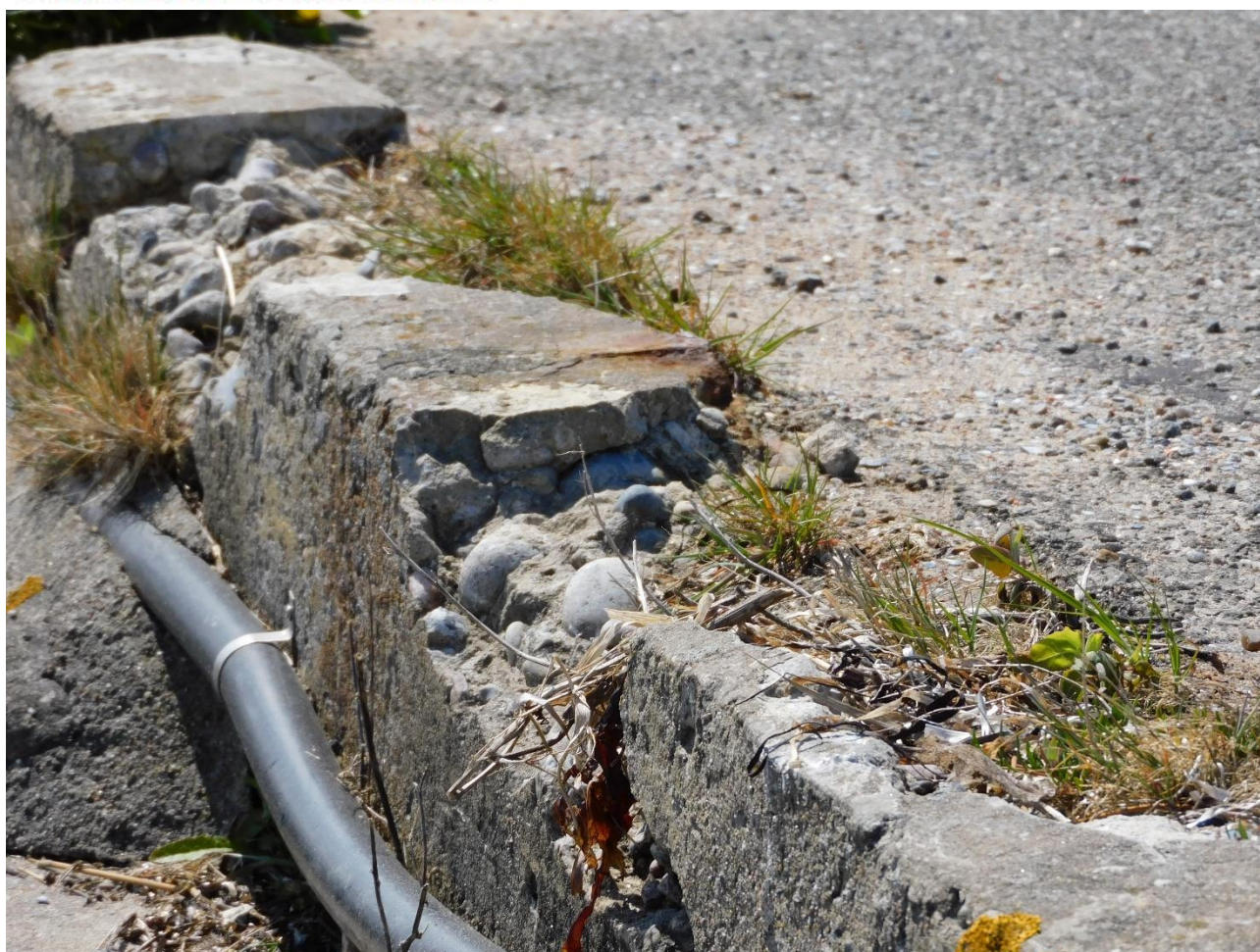
Synlig lamineret korrosion på spunsvæg
