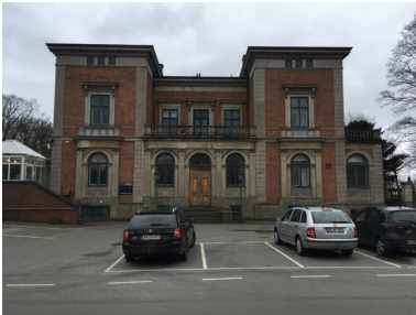
Foto af Amtmandsvillaen fra den fælles parkeringsplads mod nord. Villaen er inspireret af italiensk byggestil og opført i røde mursten og sandsten. Taget er udført i kobber og naturskiffer. Grønne vinduer og dører understreger det italienske udtryk.
