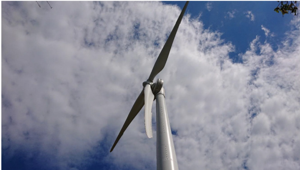
Figur 9: Den nordlige mølle med påmonteret "bagudvendte takker" på de yderste 30% af vingerne. Foto fra Notat N6.089.19 af 5. december 2019 udarbejdet af SWECO.
