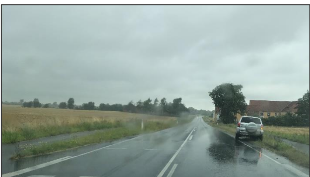
Foto 16c: Nuv. forhold, syd for Broholmsvej: Cykelsti i begge sider med bred skillerabat.
