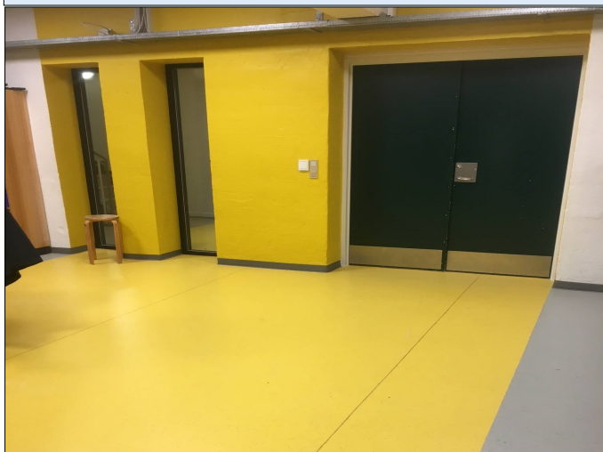
Nyt gulv samt montering af vinduer
