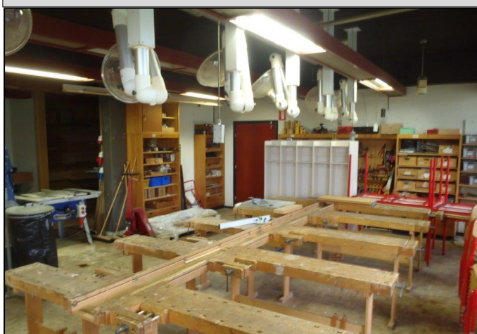
Nyt udluftningssystem med energivenlige motorer
