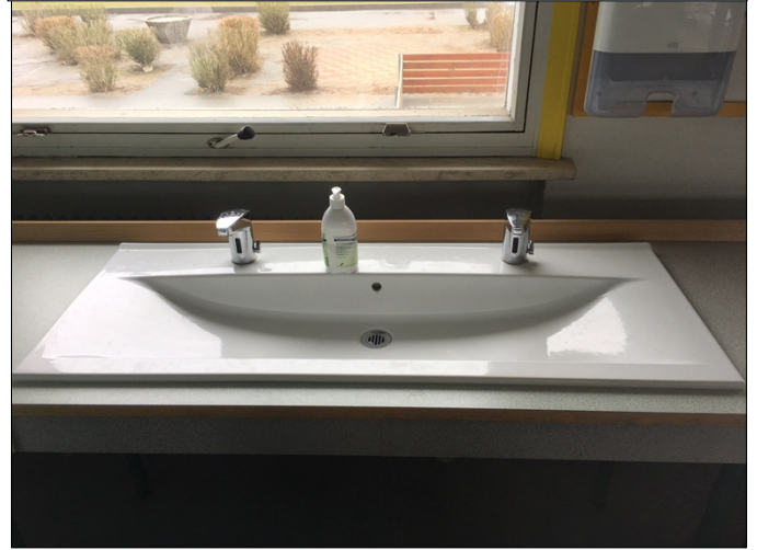
Montering af vask ved indgang til lokalet
