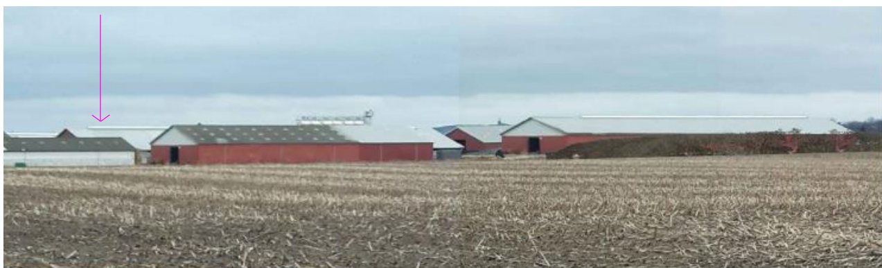
Biogasanlægget og husdyrbruget set fra Udflyttervej. Biogasanlægget ligger skjult bag husdyrbrugets bygninger, vist ved pilen.
