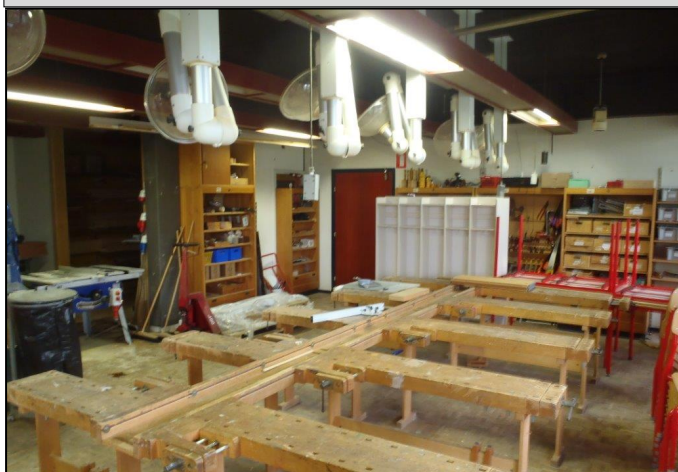
Nyt udluftningssystem med energivenlige motorer
