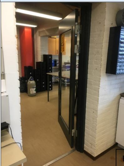
Montering af glasdør
