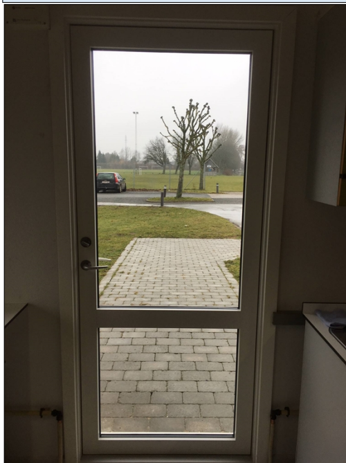
Montering af dør
