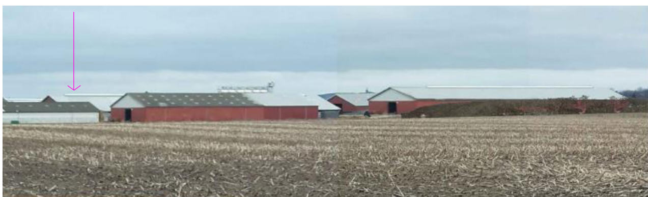
Biogasanlægget og husdyrbruget set fra Udflyttervej. Biogasanlægget ligger skjult bag husdyrbrugets bygninger, vist ved pilen.
