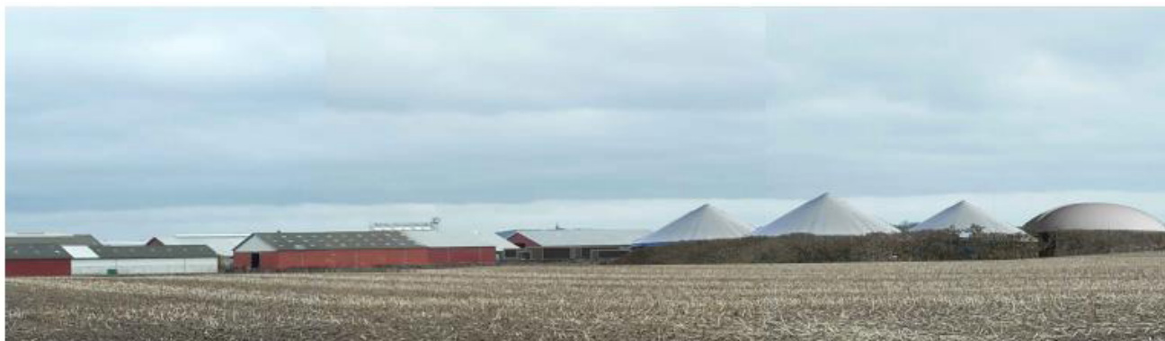
Biogasanlægget og husdyrbruget set fra Kragekærvej. Der er plantet nyt levende hegn foran anlægget. Tankene er vist med ca. 14 m højde og det nye levende hegn med ca. 7-8 m højde.
