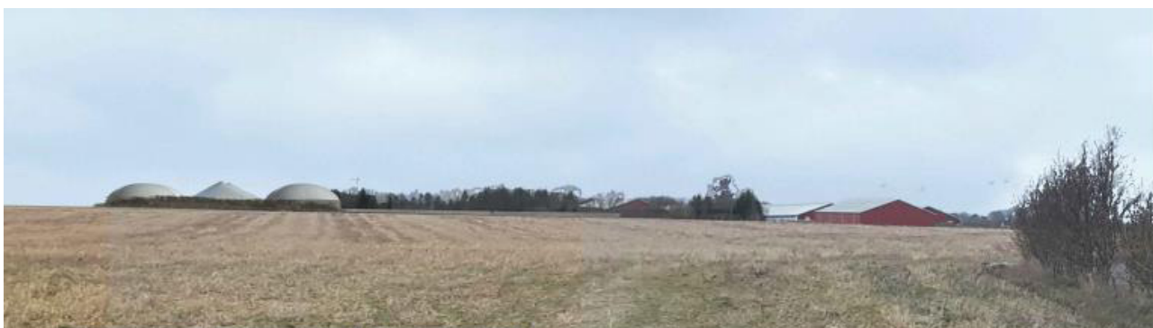
Biogasanlægget og husdyrbruget set fra Gesinge. Der er et eksisterende levende hegn foran anlægget og en del af husdyrbruget. På visualiseringen er det levende hegn beskåret.
