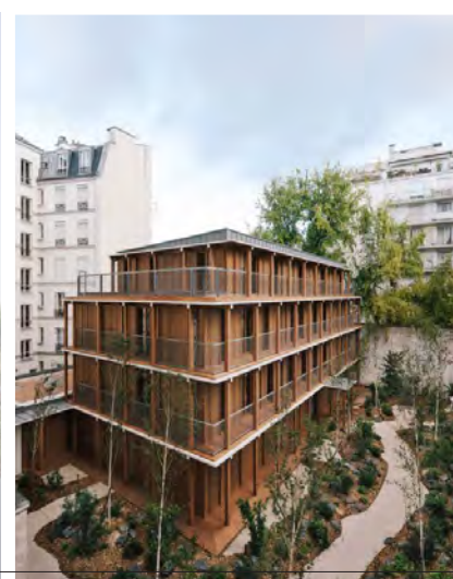
Træ facade indeliggende altaner.
