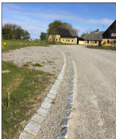
Eksempel fra lokalplanområdet på åben rende til afledning af regnvand
