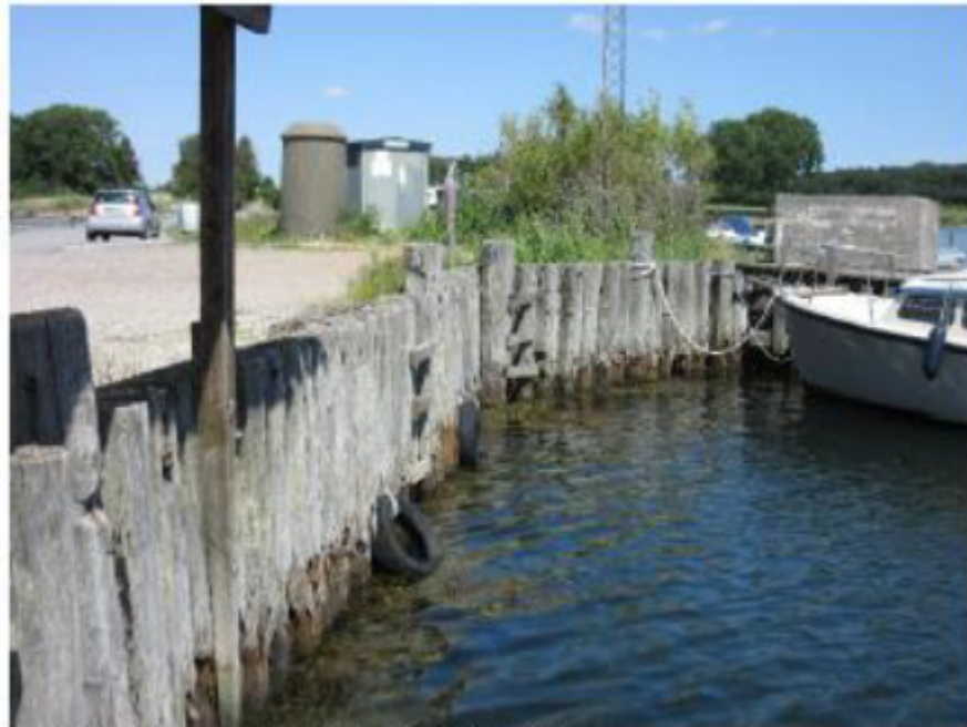
Oversigt over østsiden ved kajindfatning
