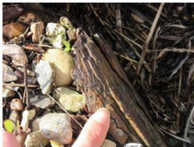
Synlig lamineret korrosion på spunsvæg
