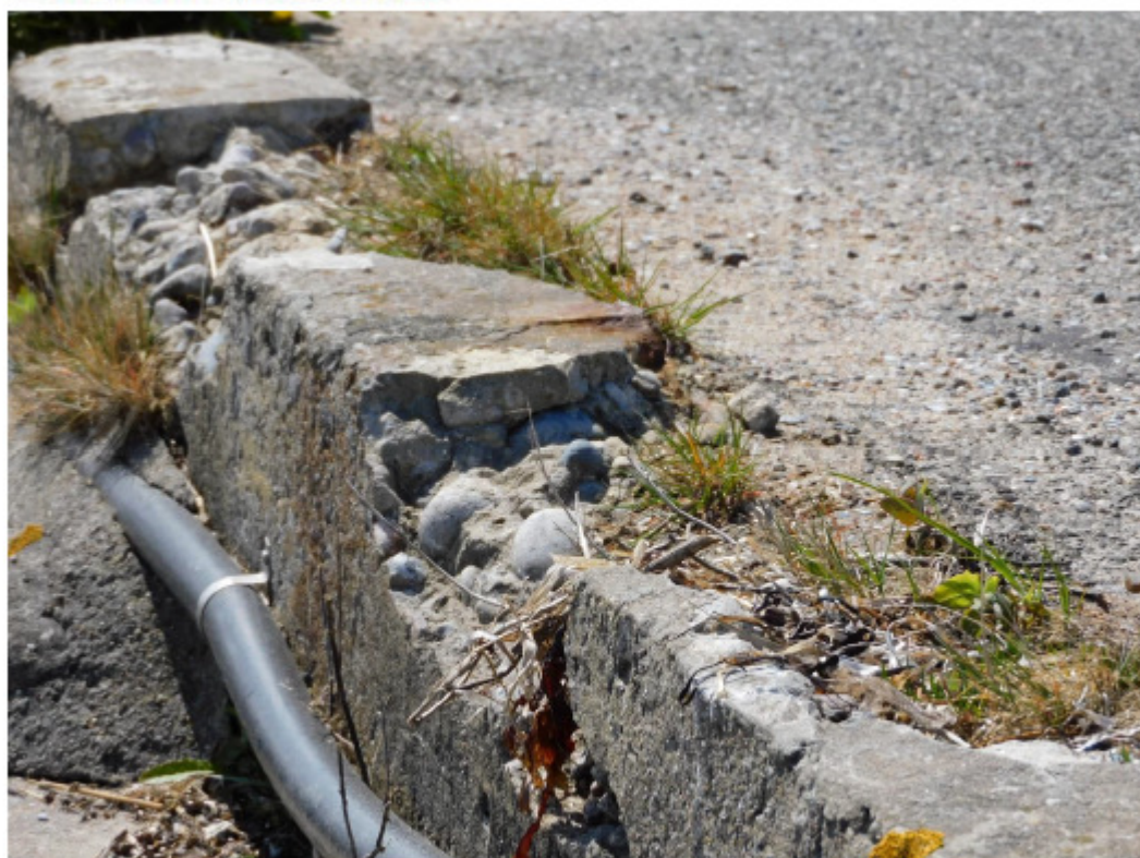
Synlig lamineret korrosion på spunsvæg
