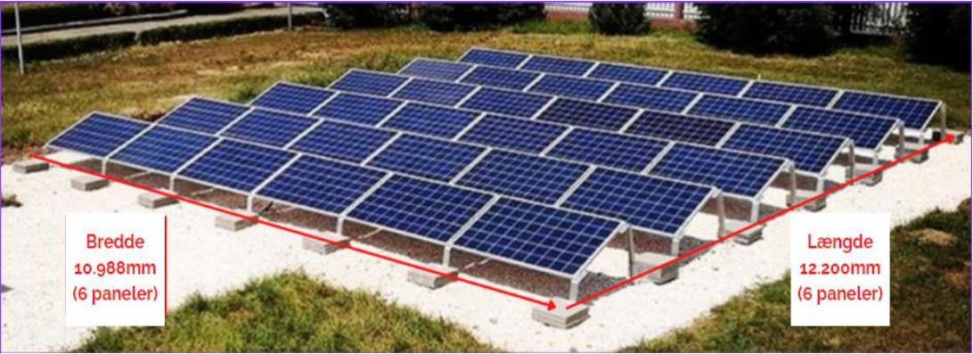
Tegning med angivelse af længde og bredde (6 rækker af hver 6 paneler, markeret med gult i opslagsliste med mål)
