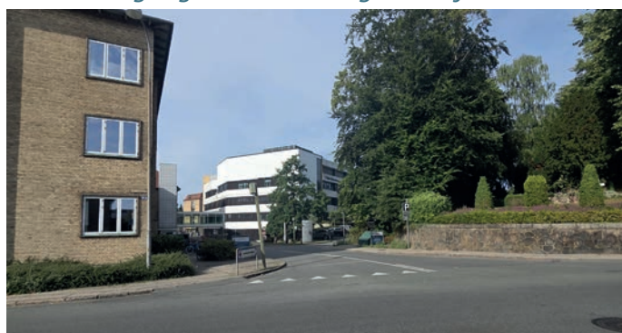
Adgang fra Valdemarsgade, skadestuen er placeret til højre efter indkørsel til området.
