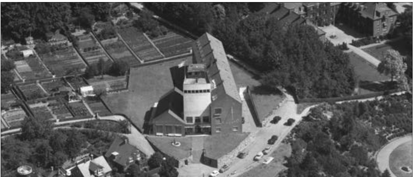
Skråfoto fra 1959 som viser den relativt nybyggede navigationsskole. Der blev tilføjet yderligere to bygningsslængere til komplekset i 1977 og 1995. Kilde: Det Kongelige Bibliotek - Danmark set fra luften
