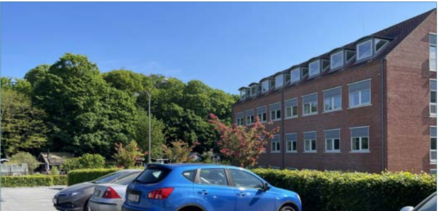
Bygningen der er tilføjet til komplekset i 1995 set fra parkeringsarealet. Foto 2025.
